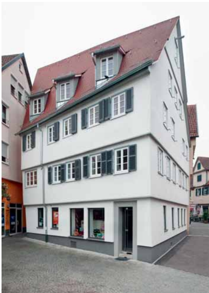
Sanierung eines historischen Wohn- und Geschäftshauses, Schorndorf
