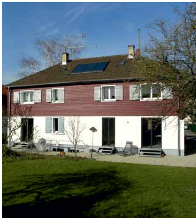
Erhalt des ursprünglichen Charakters auch nach der Sanierung
