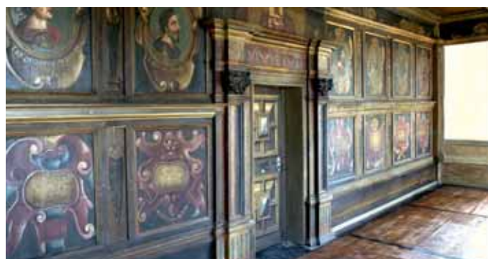
Rittersaal nach der Sanierung und Restaurierung
