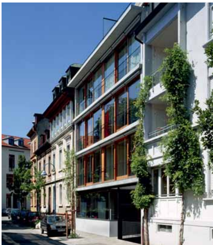
Straßenfassade - Behutsame Integration in den Bestand
