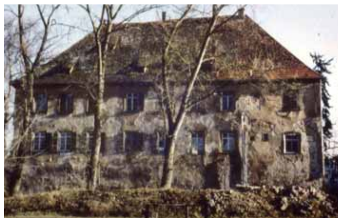
Gebäudezustand vor der Sanierung
