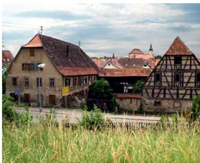
Zustand vor der Sanierung
