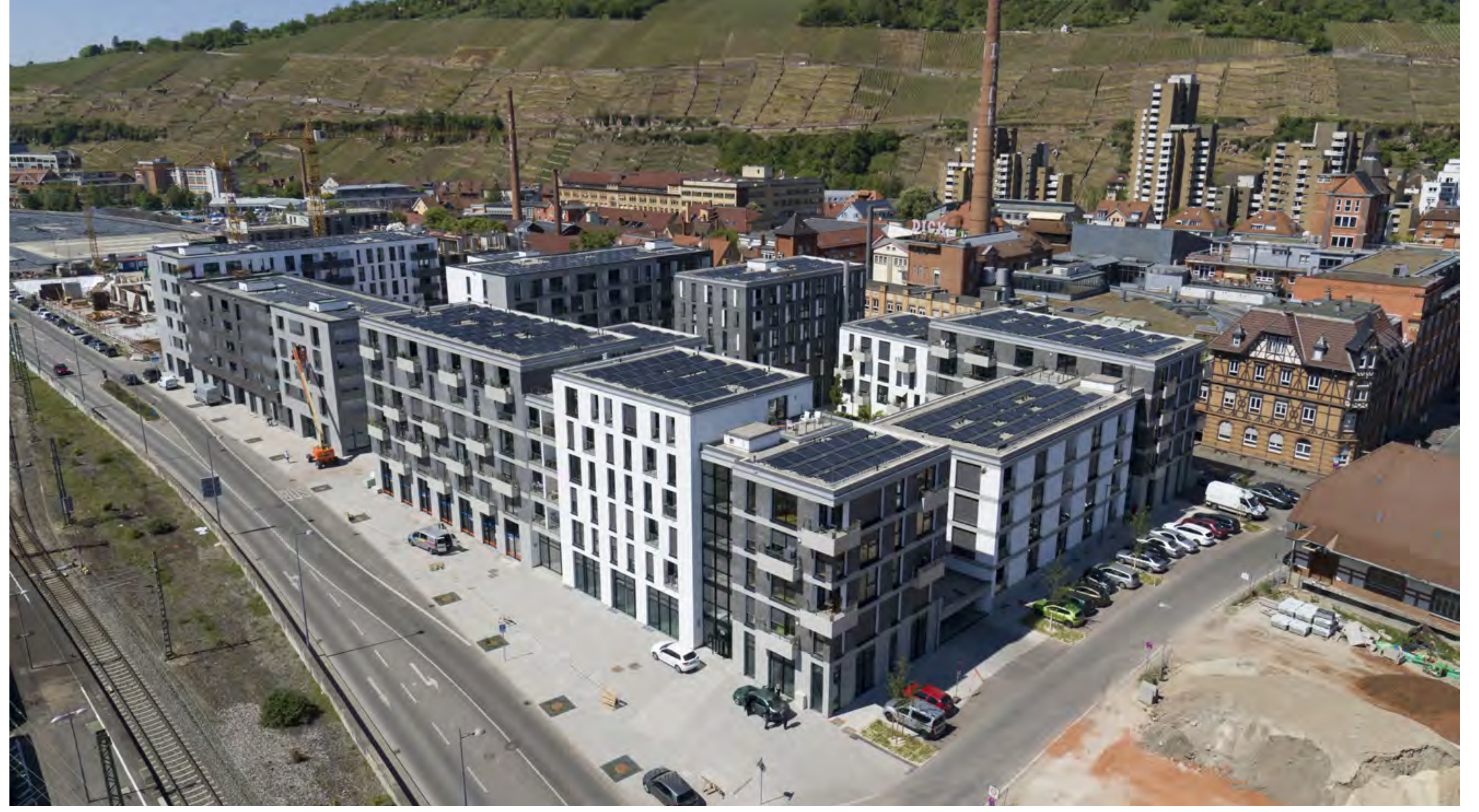
Das dicht bebaute Quartier nutzt das Neckarufer zur Naherholung. 1010
