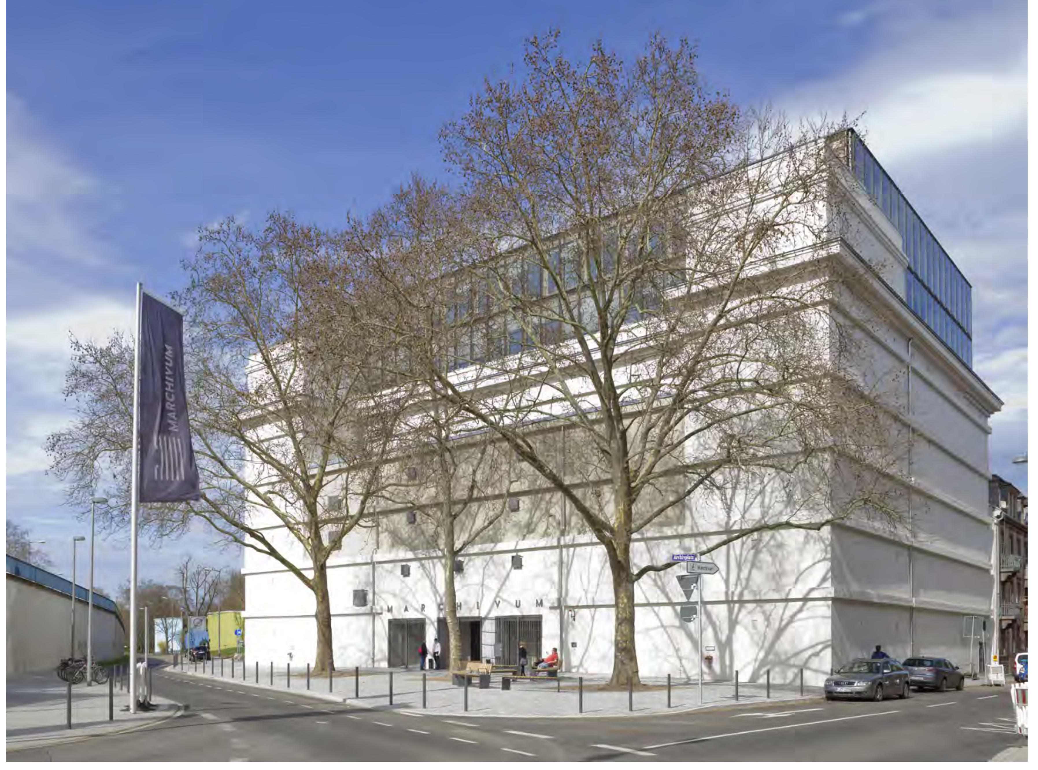
Ein unbequemes Denkmal wurde zum lebendigen Ort, dem Haus für Stadtgeschichte. (18.03)
