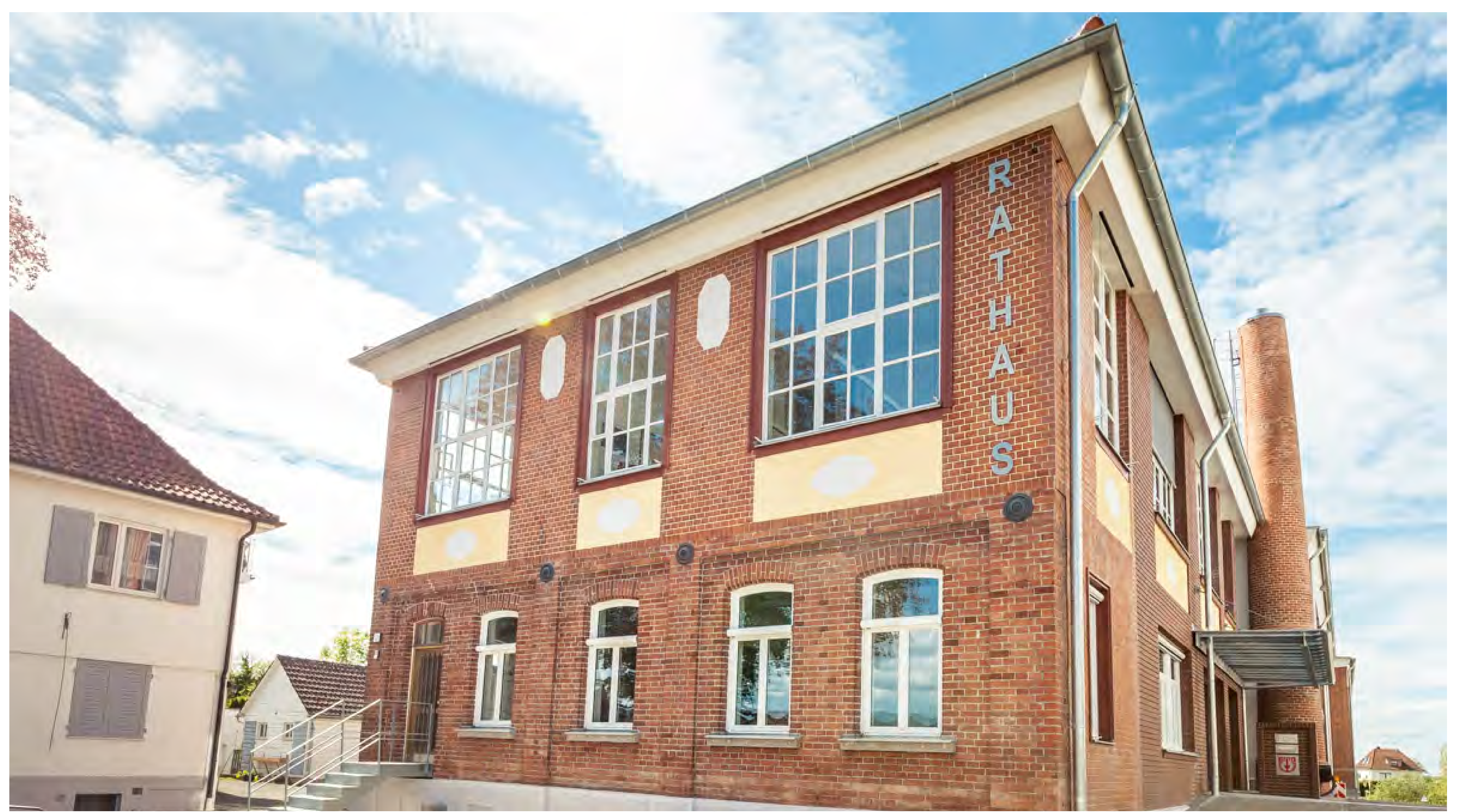
Nach acht Jahren Leerstand arbeitet in dem 80 m langen Gebäude heute die Gemeindeverwaltung. (18.03)
