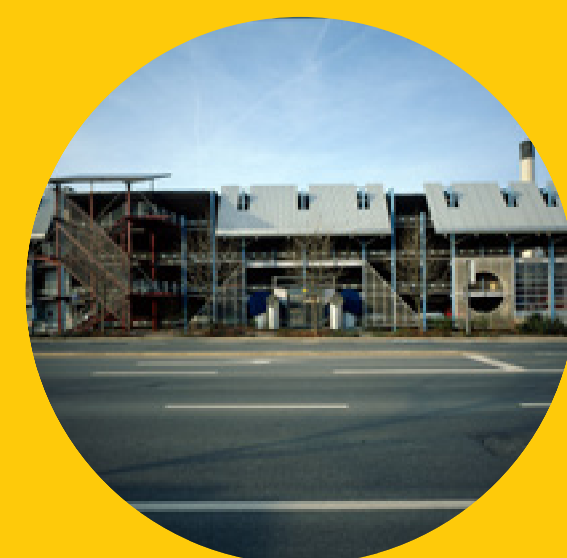
Ansprachende Gestaltung eines Parkhauses. [18]
