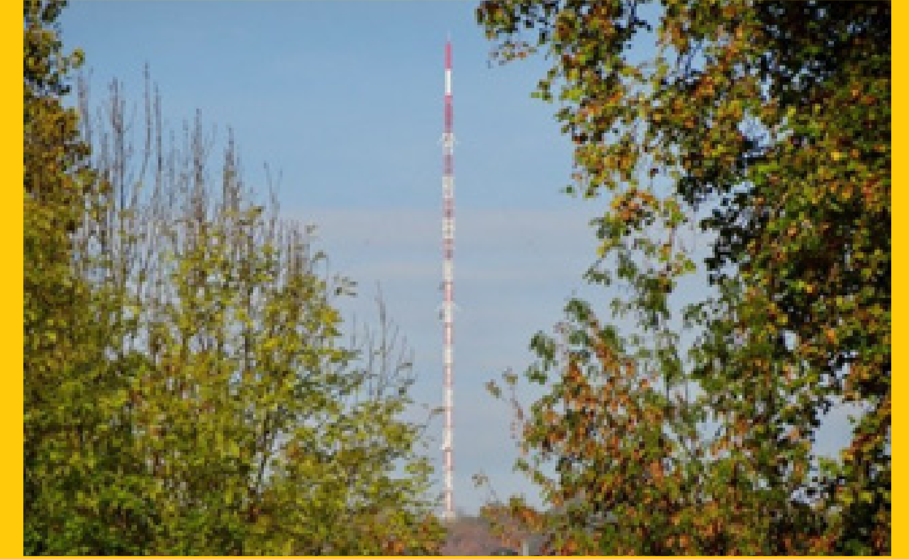
Beinahe wäre statt des heutigen Fernsehturms ein solcher Stahlgittermast errichtet worden. (117)
