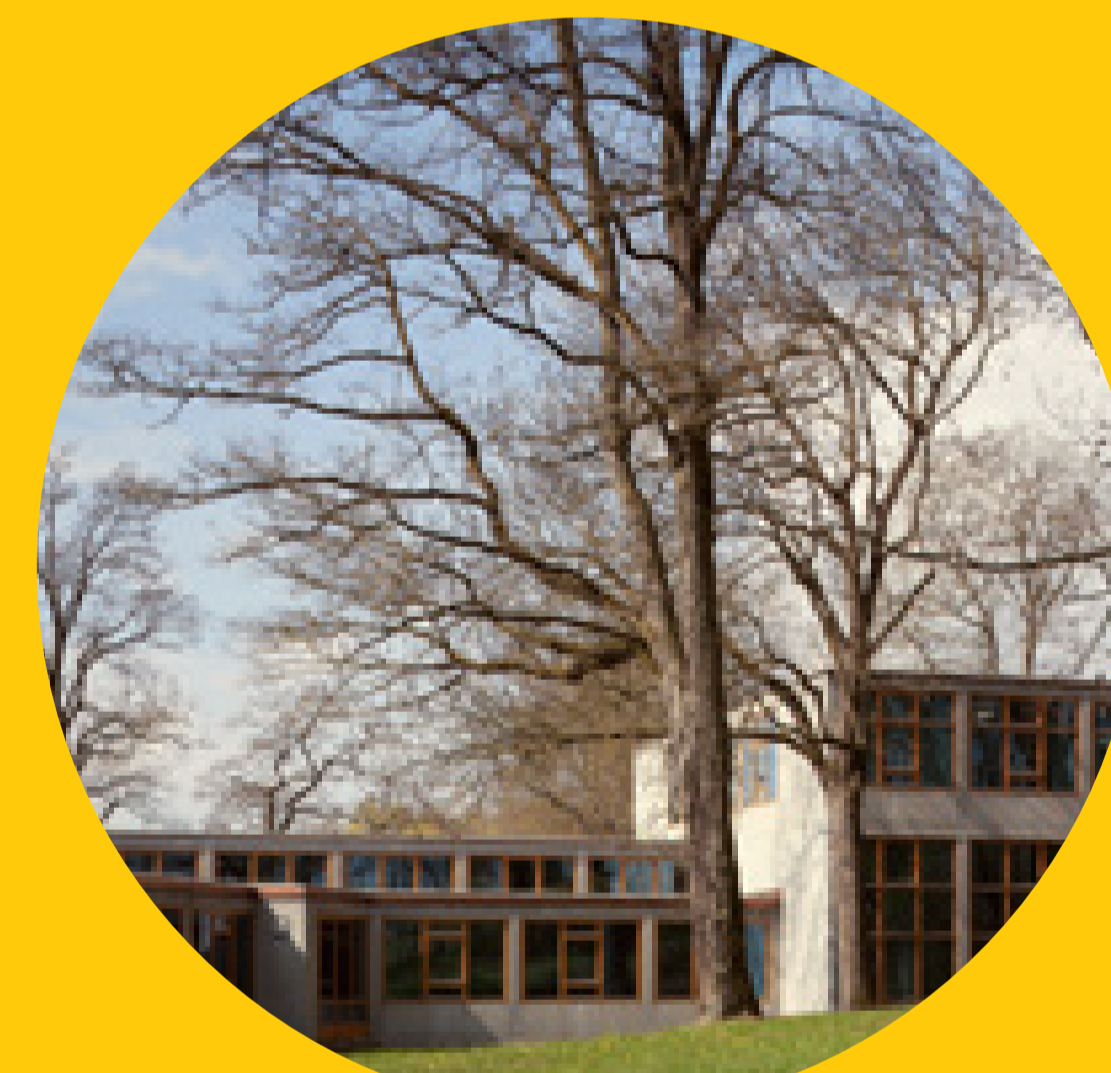
Sichtbeton und Holzfenster bestimmen die Ästhetik der Gebäude. (126)
